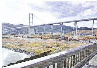
山の土を市街地に運ぶベルトコンベア。右側に盛り土の一部が見える
