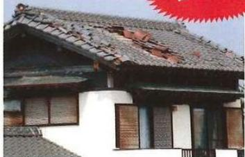
以前は釘止め基準が4枚に1枚程度の釘打ちでした。大きな台風で屋根材が飛び、隣の家に被害がおきることもあります。
