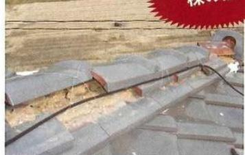
棟を銅線で固定している場合、その多くが棟芯材が入っていないため、地震時に棟が崩壊する可能性があります。
