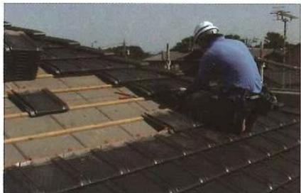
鶴弥の防災瓦にすれば屋根の重量も土葺き工法の約半分程度になります。さらにサンレイなら20%の軽量化を実現しています。
