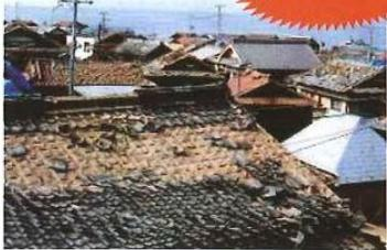
以前の土葺き工法はたくさん土を使っているため建物に負担がかかっています。また釘での固定をしていないので地震の際に瓦がズレ落ちてしまいます。
