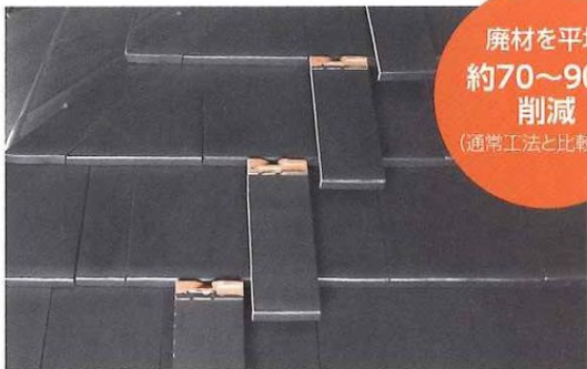
廻隅瓦を使用(調整瓦のカット後の廃材)
