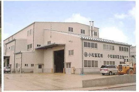
第5工場 (平成18年7月竣工)
