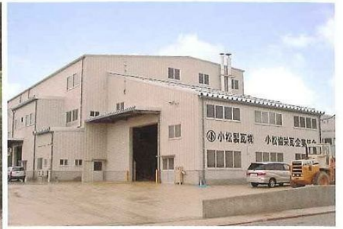
第5工場 (平成18年7月竣工)
