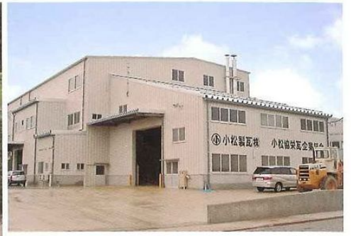
第5工場 (平成18年7月竣工)
