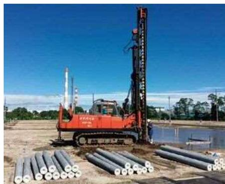
弊社が行うオチTS工法は、既製RC柱状材を押し込んで建物を支える工法です。
