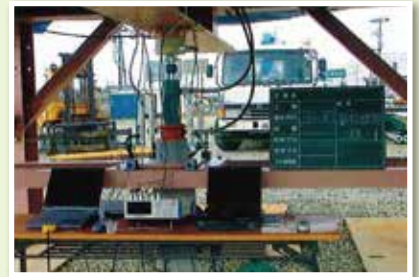
鉛直載荷試験
