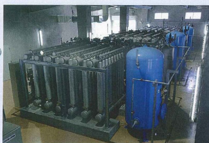
●セラミック膜浄水場設置例
