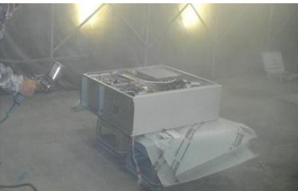
**ブロックキーパー**を油だき温水ボイラに施工中
