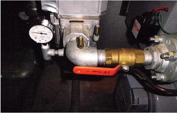
黄銅製ボールバブルのボディへ**ブロックキーパー**を施工。数年以上経過も腐食なし。無塗布状態では、数カ月でボディは腐食で黒くなり、穴が開き、漏れが発生する
