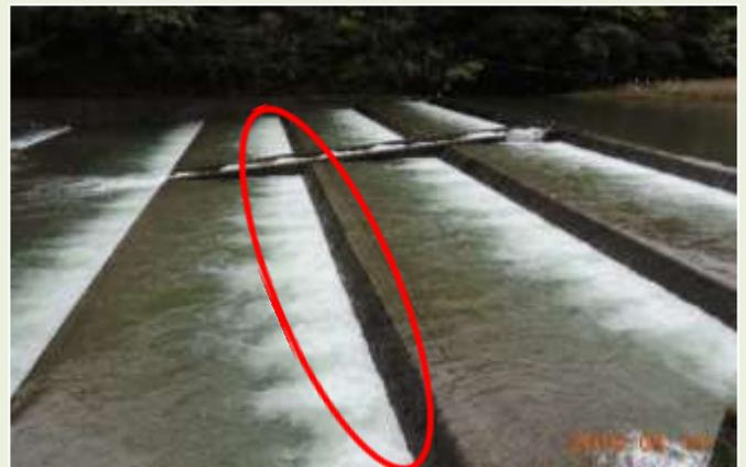
カスケード方式の魚道はポケットが作られ、出水時に堆積土砂が排出される構造になっている。自然の力を利用しているため劣化も小さく、土砂排出などのメンテナンスも少なくすむ。
