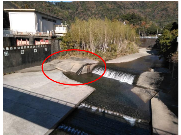
赤丸が現在の魚道、その右側が伊久美川への行き来を妨げる 2 m 以上の落差
