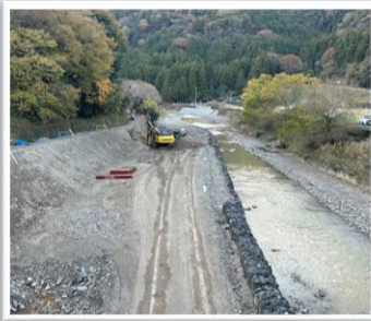
山の家付近（護岸工）
