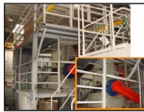
廃プラ⇒4.6t/日(8時間稼働) 木くず⇒19.6t/日(8時間稼働)
