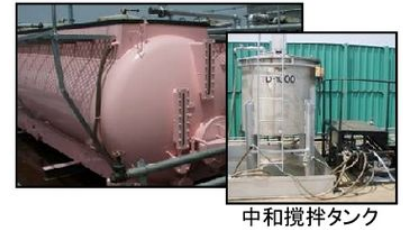
廃酸・廃アルカリ⇒加工用水 43m 3 /日(10時間稼働)
