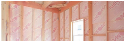
壁全面に施工された断熱材 ネオマフォーム
