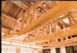
リビングの美しい梁は、樹齢1000年超えの島根県産の地松を使用。この太さだからこそ、3間の幅を柱無しで支えられるそう。
