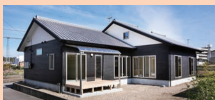
裏側の外観。物干しができるウッドデッキを設けた。サンルームとつながる動線。
