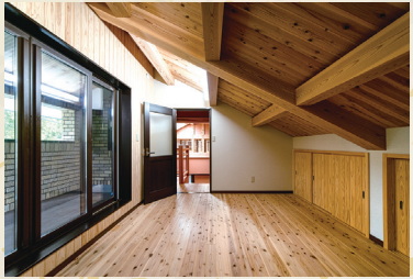
ロフトは熱がこもりやすいため、全てを無垢材で仕上げた。調湿性・消臭性が高まる。
