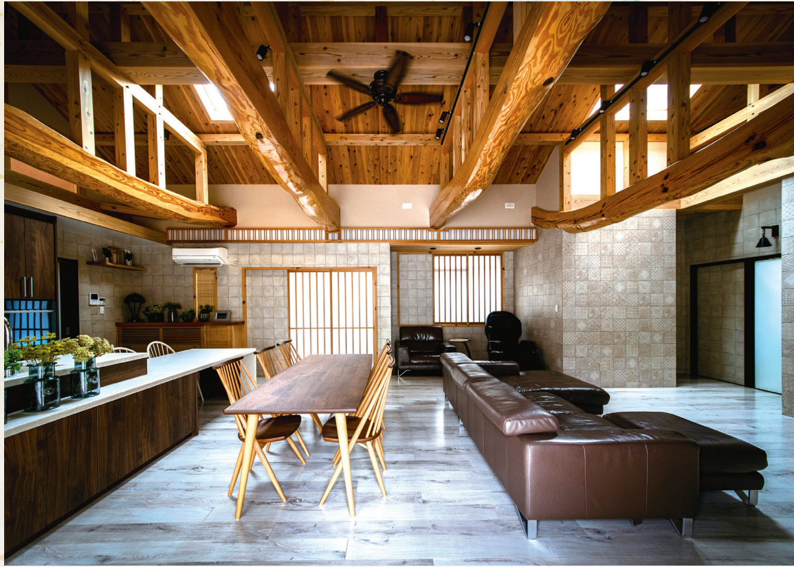
LDKには曲材の地松を施工。空間全体を吹き抜けにして、開放感を演出。柱はたてず、地松、母屋、束などで強度を確保し、大空間とした。十分な強度を持たせる木の組み方は、職人の知識と経験をフル活用している。プレカットでは実現できない価値を持たせた造りだ。
