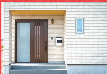
玄関は、毎日のスタートとゴールの場所。ホールも広く取り、気持ちよくスムーズに動けるようにした。
