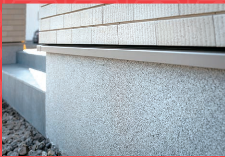
基礎には、ひび割れがしにくい材質のものを採用。大理石調で、経年変化を感じないのが特徴。
