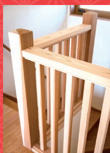
白川建設の職人が造った手すり。空間を美しく。
