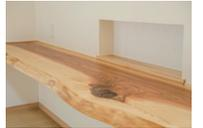
できるだけ木を感じられる仕上がりに。カウンターの一枚板のほか、棚や笠木も集成材を使わず、無垢材で施工。大きな節が木を感じさせます。
