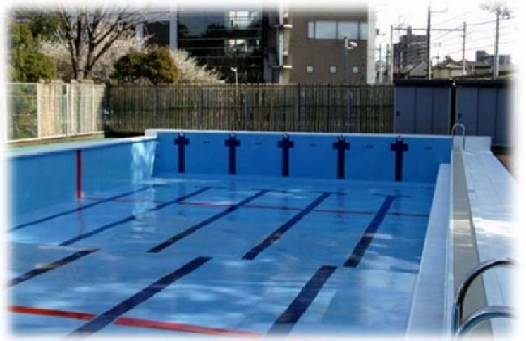
改修後・ステンレス製プール
