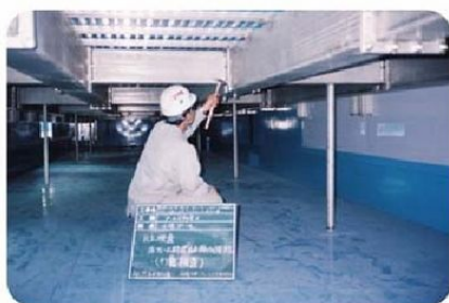
床フレーム点検
