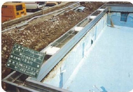
ステンレス製集合導管設置 FRP ライニング：床面 側面
