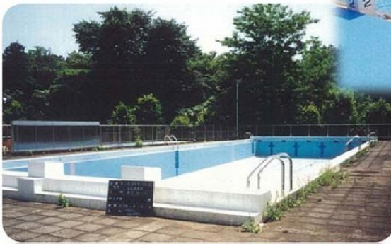
改修前：RC 製プール
