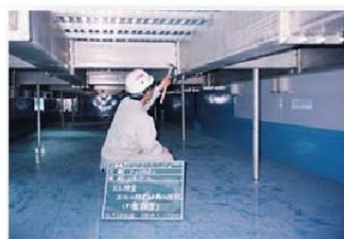
プール可動床メンテナンス
