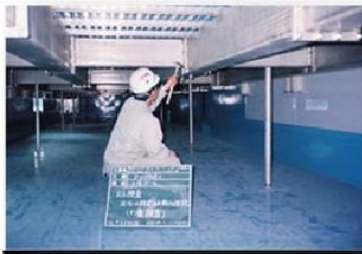
プール可動床メンテナンス
