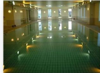
ステンレス製・タイル貼プール
