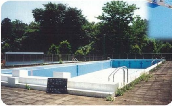
改修前：RC 製プール
