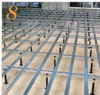
8 下地組取付け完了。
