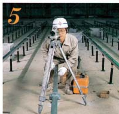
5 水平器を用い、レベル調整を行ないながら、大引を完全締付け固定する。
