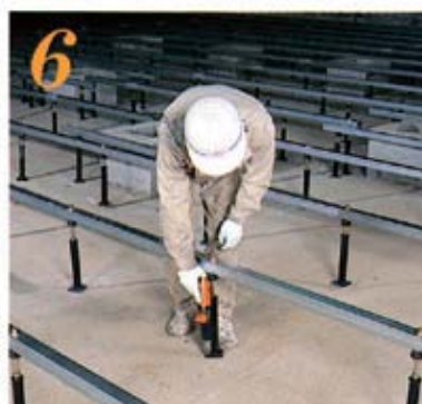
6 アンカーボルトの無い箇所は、バッファーピンで2ヶ所固定する。
