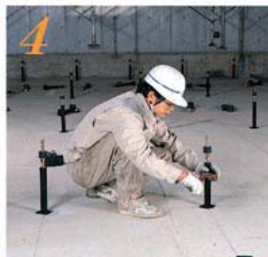
4 支持台に調整ボルト等をセットし、アンカーボルトに支持脚をネジ込む。
