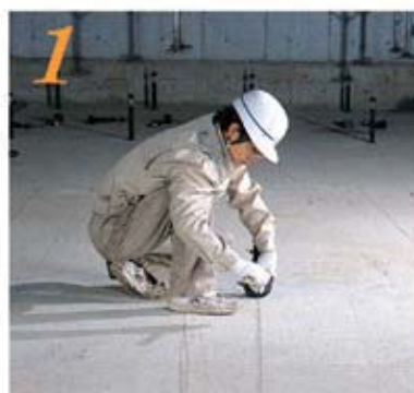
1 あらかじめ、きれいに清掃した、床スラブに墨出しを行なう。
