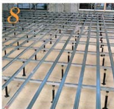
8 下地組取付け完了。
