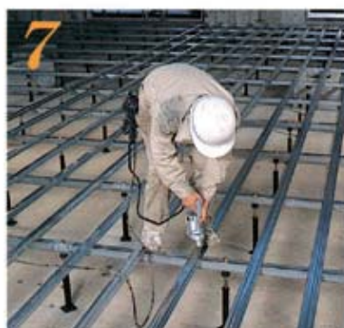
7 大引上に根太をタップ・タイトビスにて完全締付けする。
