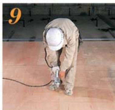
9 根太取付け後、捨張材を取付け、ドライウォールスクリーンで固定する。
