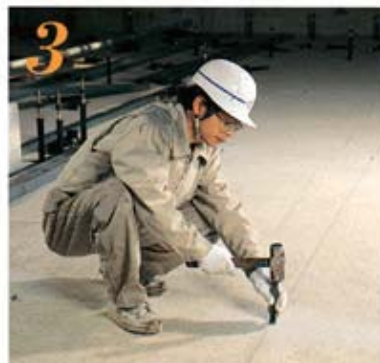
3 ハンマードリルで穴開け加工した穴にアンカーボルトを打ち込む。
