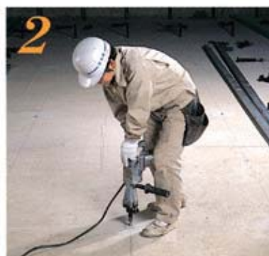
2 墨出し後、ハンマードリルで12.7φのアンカー用の穴開け作業を行なう。
