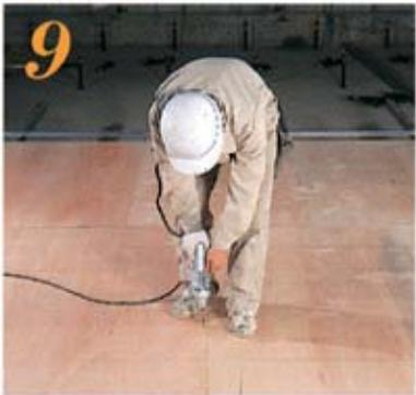
根太取付け後、捨張材を取り付け、ドライウォールスクリューで固定する。
