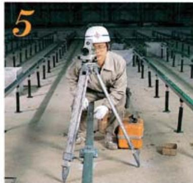
水平器を用い、レベル調整を行ないながら、大引を完全締付け固定する。
