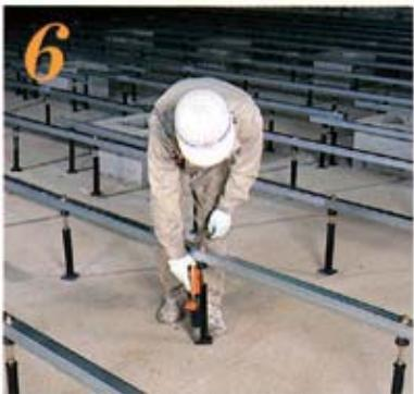
アンカーボルトの無い箇所は、バッファーピンで2ヶ所固定する。
