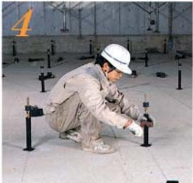
支持台に調整ボルト等をセットし、アンカーボルトに支持脚をネジ込む。
