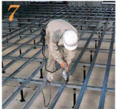
大引上に根太をタップ・タイトビスにて完全締付けする。
