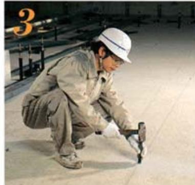
ハンマードリルで穴開け加工した穴にアンカーボルトを打ち込む。
