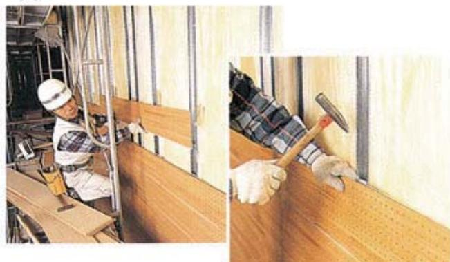
\*表面仕上材は木質吸音孔ボードのほかに不燃・準不燃用有孔パネルがあります。多目的に使用できます。
