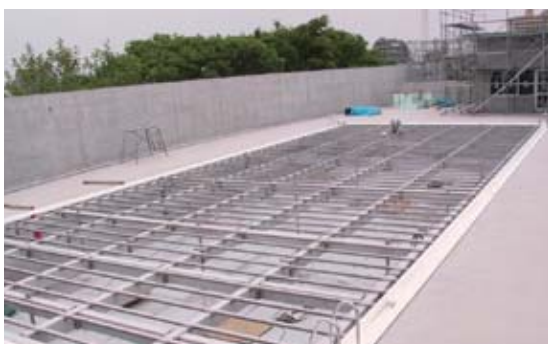
フロート式床フレーム
