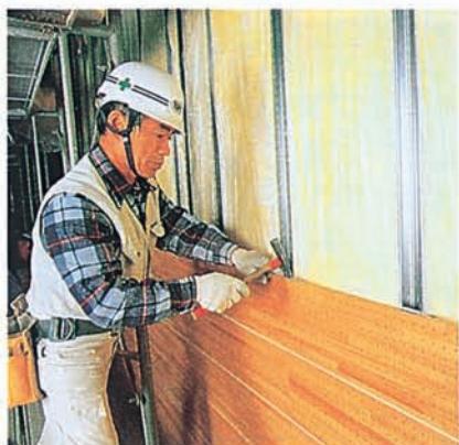
木製下地材組工法と異なり、ロールフォーミング材の精度の高い「鋼製スタッフ」を使用しており、表面が平滑に仕上ります。また、仕上げ材の取付けも特殊金具によりワンタッチで簡単に取付けられるため、現場での作業が大幅に短縮できます。
