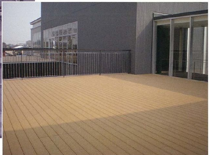
(栃木県某福祉センター)
