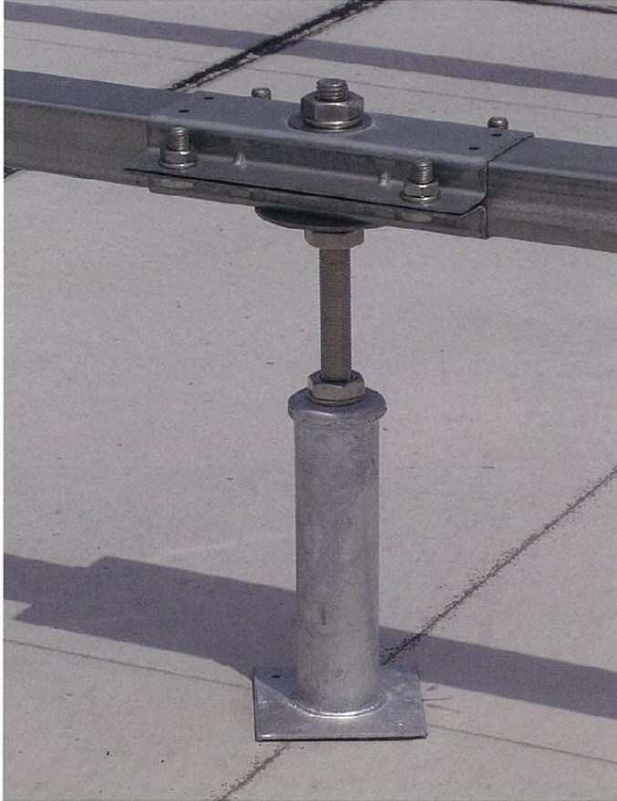
写真は太引ジョイント部です
