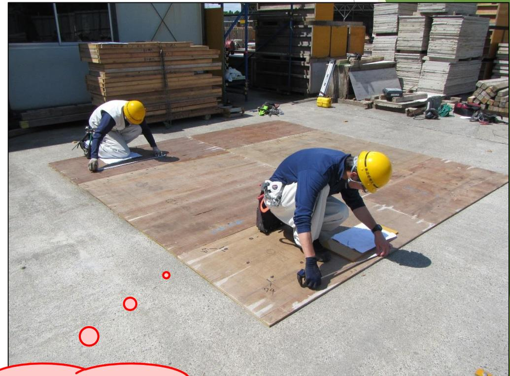
画像では練習のためベニヤ板に墨出しをしています。現場ではコンクリート床の上に墨出しをします。
