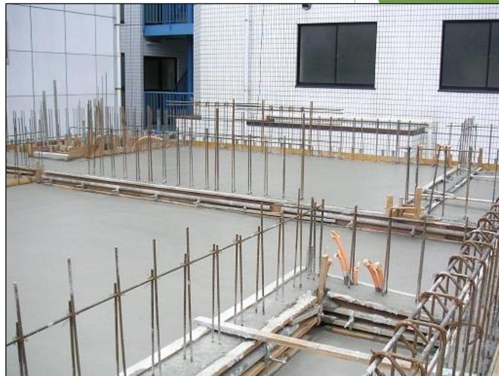
コンクリート打設は別業種が行いますが、同時に打設前点検、及び打設中の型枠の点検は型枠大工さんの仕事です。
