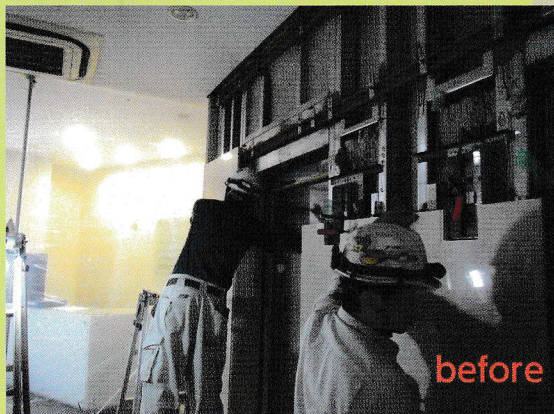
○石材取付施工例
