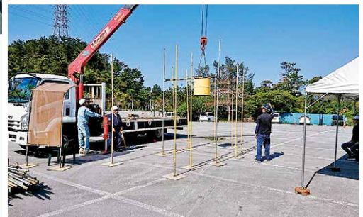
小型移動式クレーン運転実技講習
