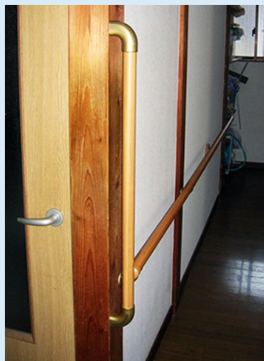
廊下の手すり
