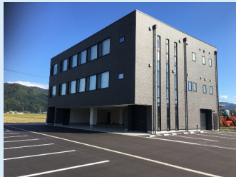
3階建て鉄骨造事務所
