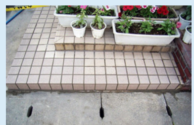
その他 玄関タイル修繕
