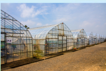
●ビニールハウス暖房設備
