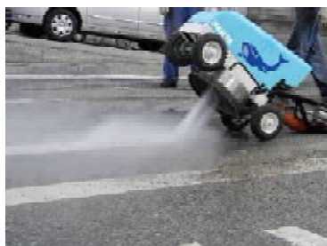
超高压水噴射状況
