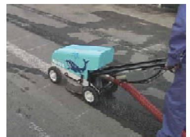
白線除去作業
