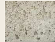
合板型枠のみ
