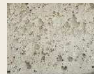
合板型枠のみ
