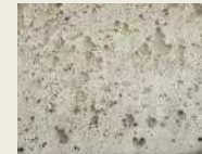
合板型枠のみ
