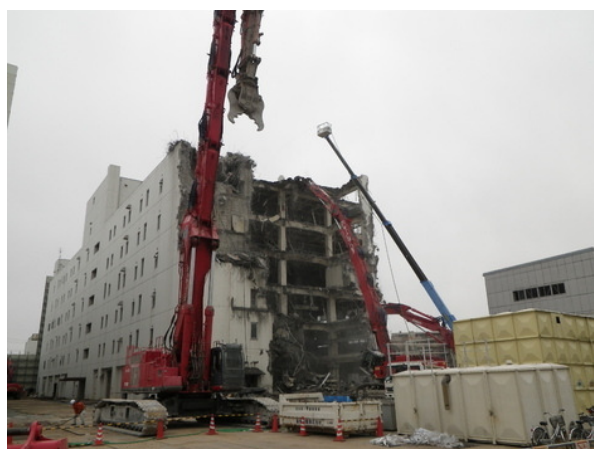
建物解体工事
