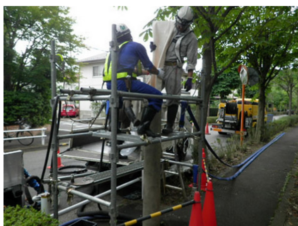
管渠更生工事
