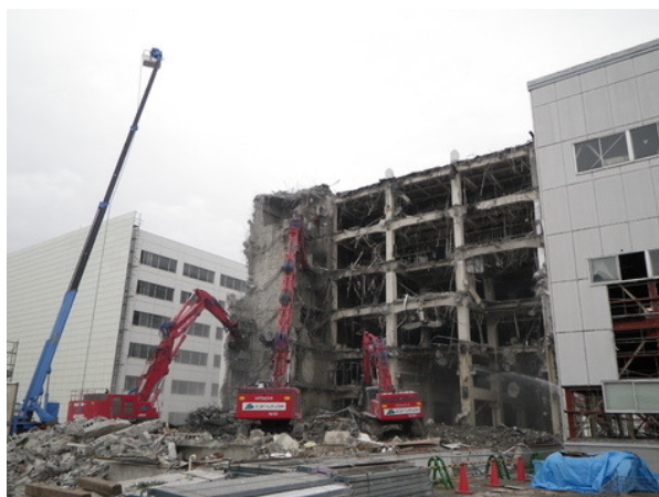
建物解体工事
