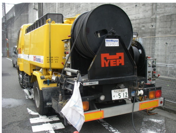
管渠更生工事
