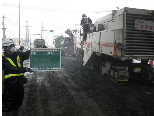
道路舗装工事
