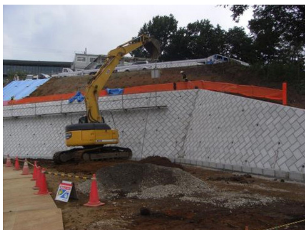
グラウンド造成工事
