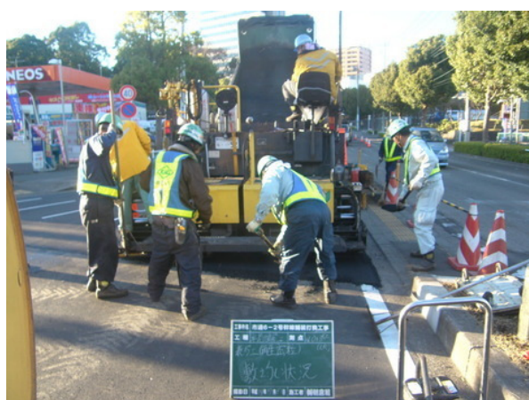
道路舗装工事
