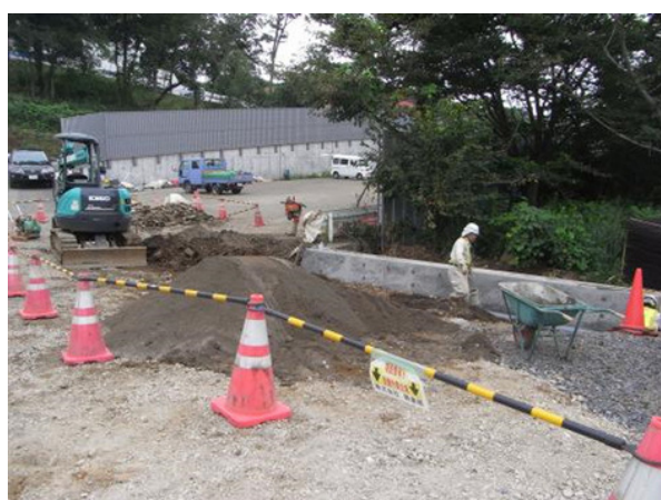
グラウンド造成工事
