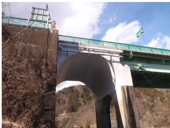
橋梁土木工事
