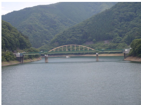
橋梁土木工事
