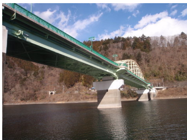
橋梁土木工事
