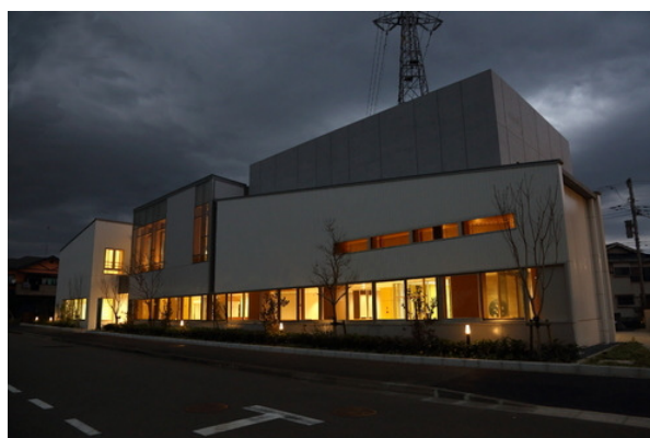
コミュニティーセンター新築工事
