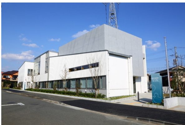
コミュニティーセンター新築工事
