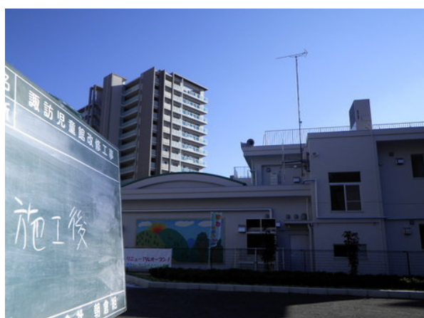
児童館改修工事
