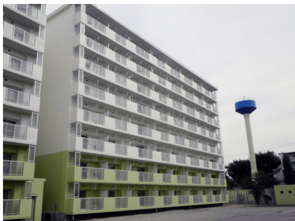
集合住宅新築工事
