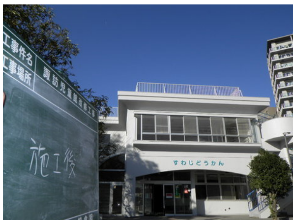
児童館改修工事
