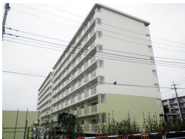
集合住宅新築工事
