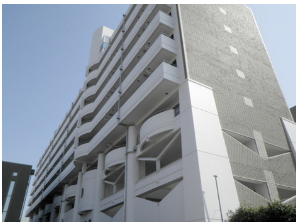
集合住宅改修工事
