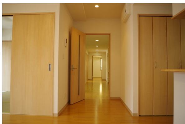
寄宿舍新築工事
