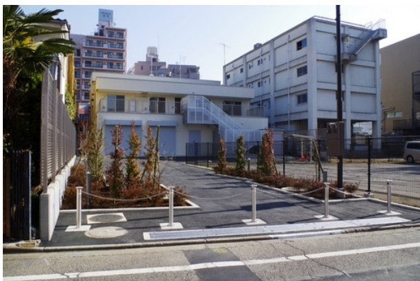
寄宿舍新築工事
