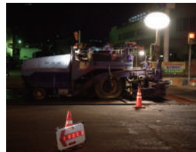
工事現場使用例
