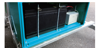
100Ahの大型バッテリーを搭載。
