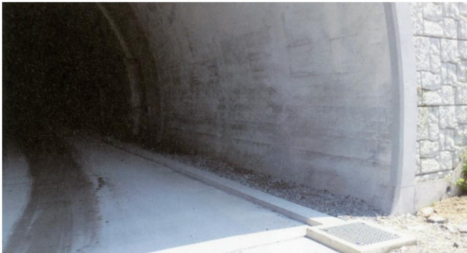
※セントレーン側溝と歩車道境界ブロックが共に製品長が2.5mである為、一組での施工が可能となります。また、長さ方向の調整が不要になり工期短縮を実現します。
