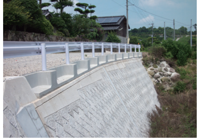
ブロック積み擁壁
