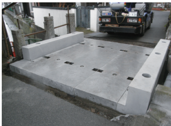
床版施工完了
