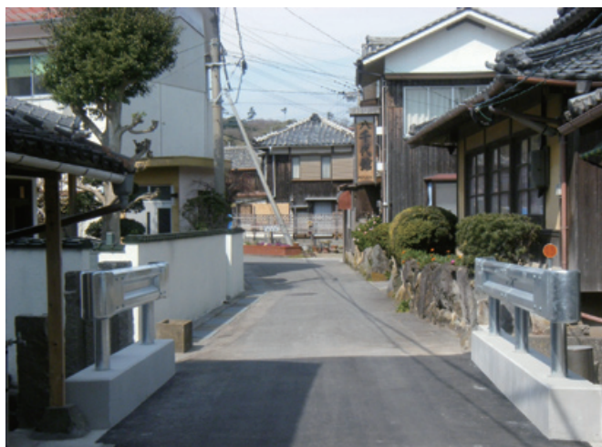
舗装・ガードレール設置完了
